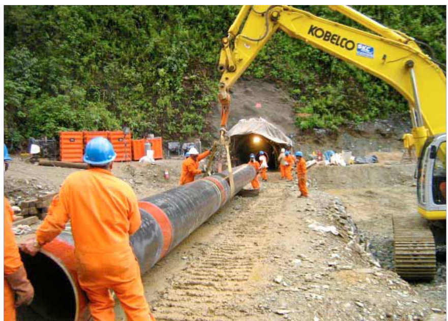
▲ Construcción de ducto en la selva / ©Transportadora de Gas del Perú
