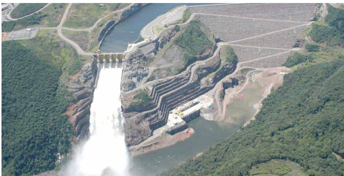
◀ Ejemplo de una presa de enrocado con revestimiento de concreto en Brasil / ©Egasur
